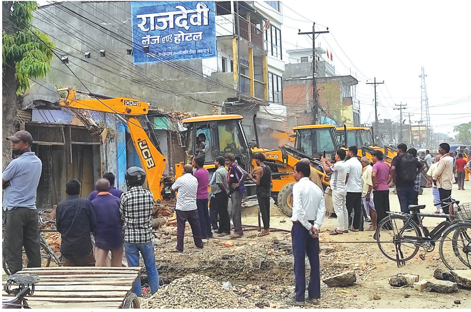
सप्तरीको राजविराजस्थित मुख्य सडक छेउ अतिक्रमण गरी बनाइएका संरचना तथा पेटी डोजर लगाएर भत्काउँदै ।
